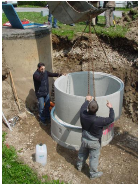
Slika 23: Nameščanje novega lizimetra (Foto: Polona Cesar, 21.05. 2010)
