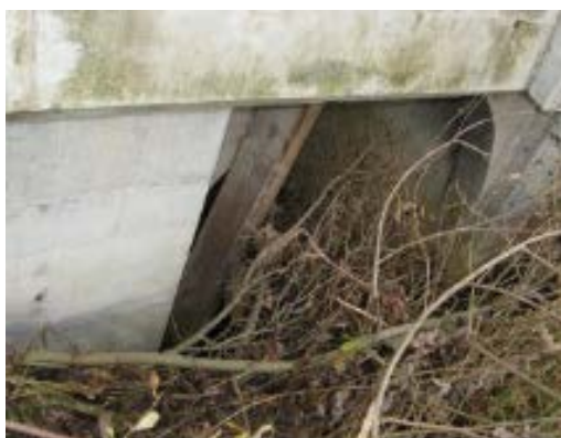
Slika 13: Premajhen in delno zamašen mostni prepust in cesta kot visokovodni nasip
