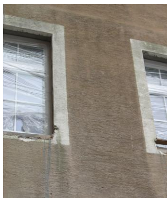
Slika 4-37: Zaradi prevelike vlage je fasadni omet v propadanju.
