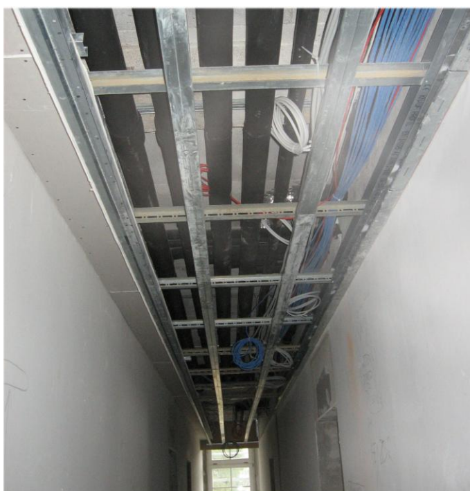
Slika 4-44: Spuščeni stropovi.
