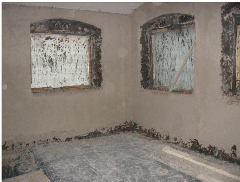
Slika 4-27: Na novo izveden sanacijski omet.
