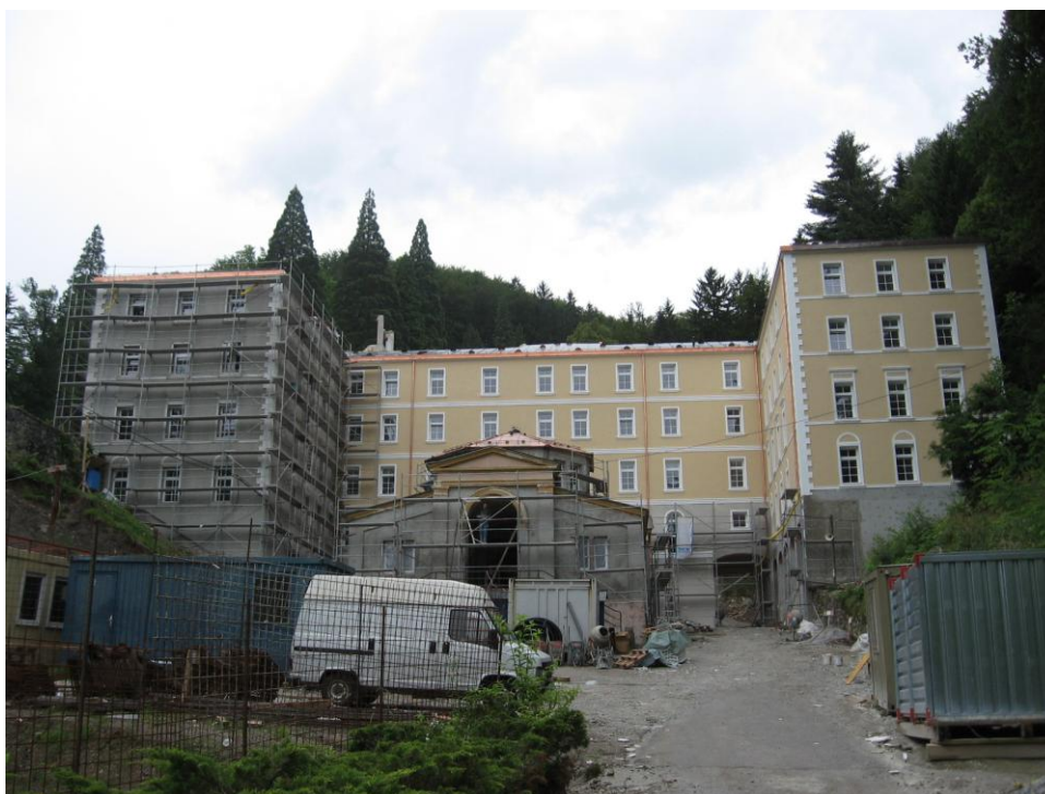
Slika 5-2: Pogled na severni del stavbe.
