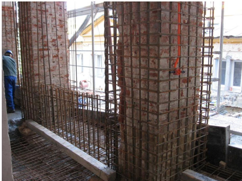
Slika 4-13: Ojačitev stebrov z armaturo.
