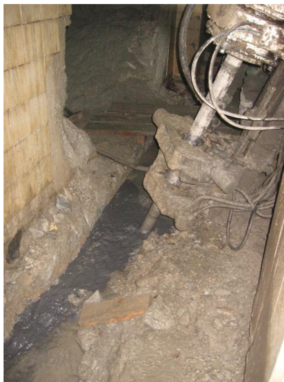
Slika 4-3: Injektiranje cementne suspenzije.
