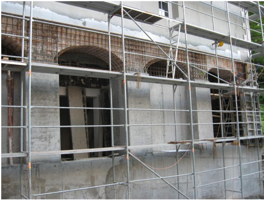
Slika 4-14: Obbetoniranje stebrov.
