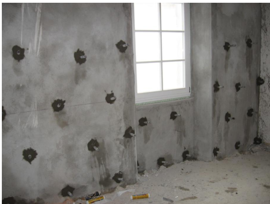
Slika 4-20: Injektiran zid.
