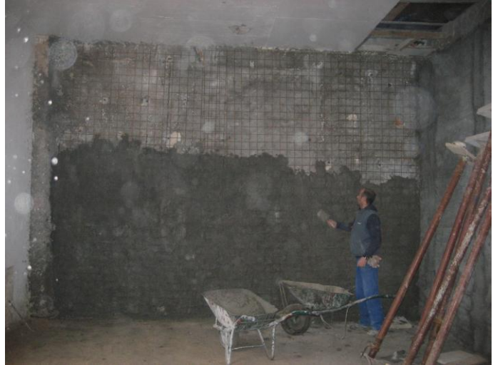
Slika 4-22: Izdelava armirano-betonskega
