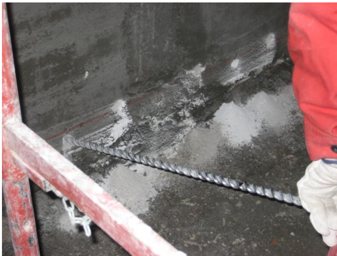
Slika 4-27: Vrtanje odprtin za injektirno maso.
