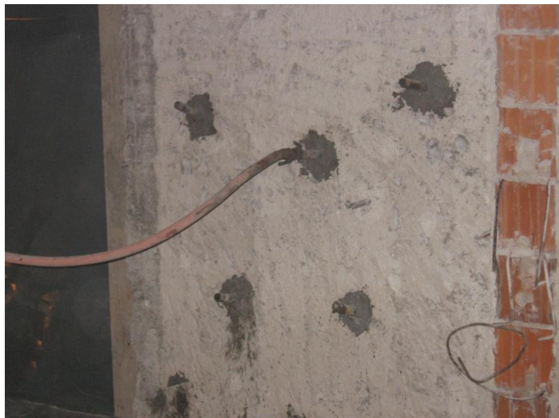
Slika 4-19: Injektiranje.
