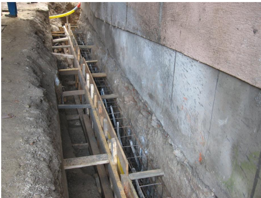
Slika 4-5: Položitev armature za gredo.
