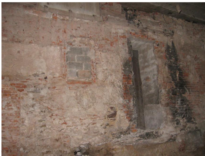
Slika 4-10: Heterogena zasnova nosilnih zidov.
