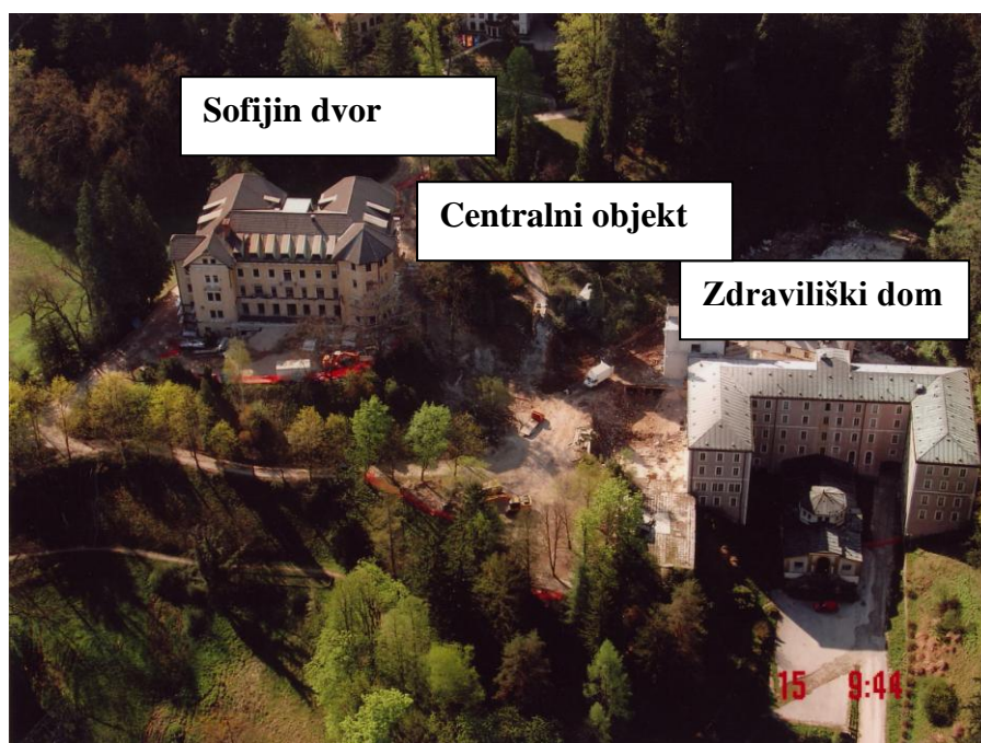
Slika 3-2: Pogled na zdraviliške objekte.
