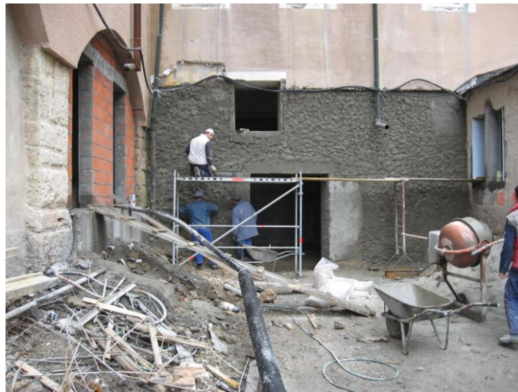
Slika 4-38: Do višine 2 m je bilo treba odstraniti obstoječo fasado.
