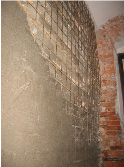
Slika 4-21: Armirano-betonski omet.
