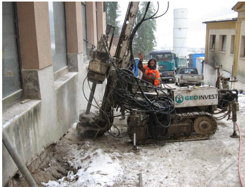
Slika 4-2: Vrtanje pilotov.
