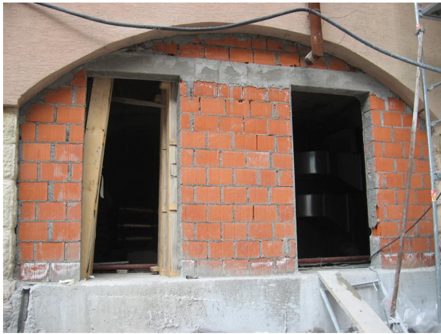
Slika 4-15: Dodani zid za zmanjšanje obremenitve.
