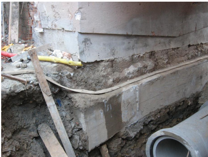
Slika 4-6: Obbetoniran temelj.
