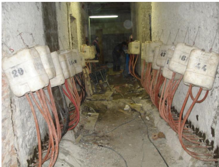
Slika 4-28: Hidrofobiranje.
