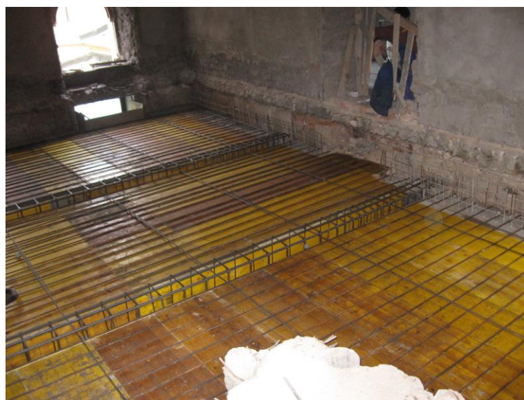
Slika 4-43: Položena armatura in priprava za betoniranje AB-plošče.
