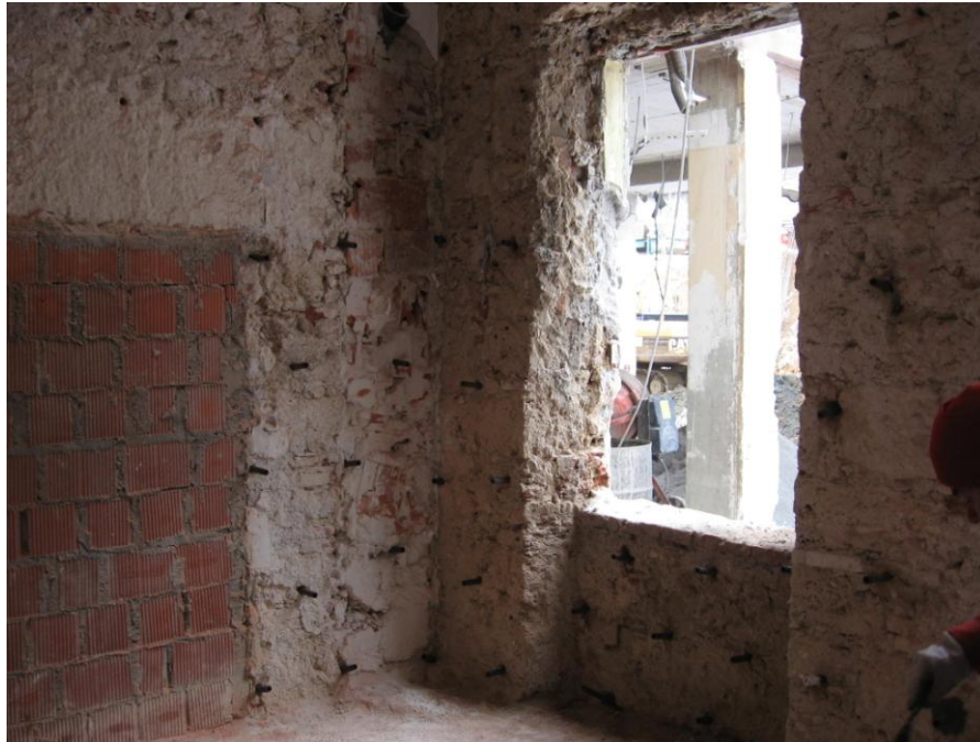
Slika 4-18: Vgraditev injektirnih cevk.
