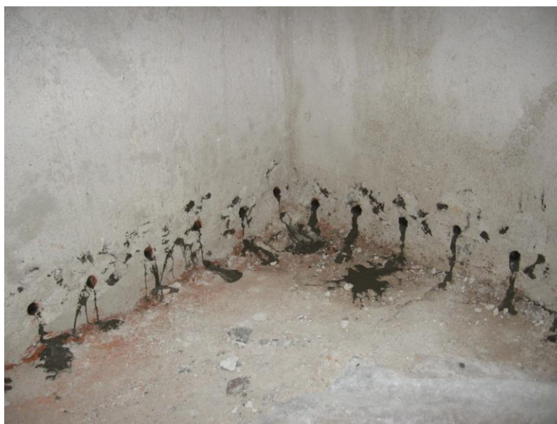
Slika 4-29: Zaplnitev z hidroforobno malto.
