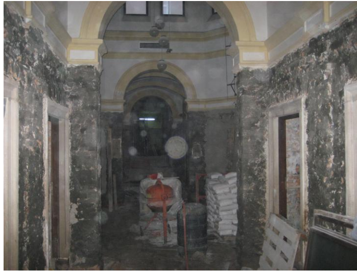
Slika 4-25: Utrjevanje površine z utrjevalcem gradiv.
