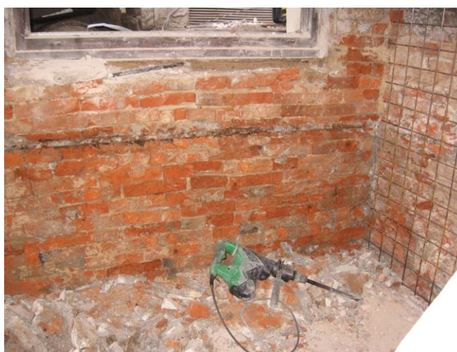
Slika 4-24: Odstranitev ometa.
