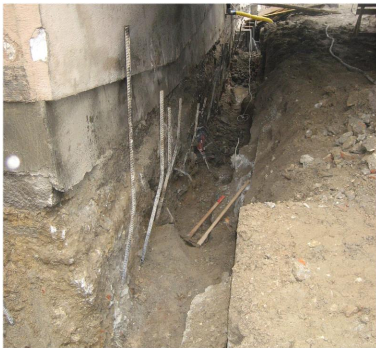
Slika 4-4: Izkop za armaturo grede.
