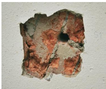
Slika 4-9: Primer izvedene sonde.
