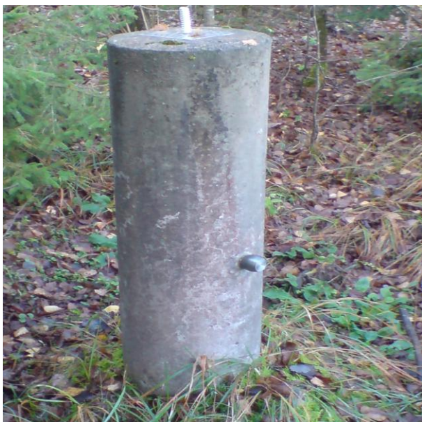
Slika 8: Stabilizacija reperja na opazovalnem stebru 6001
