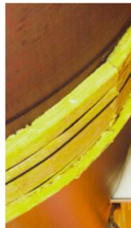
Slika 14: Izolacija plašča rezervoarja
