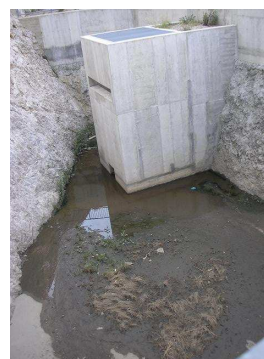
Slika 30: Ponikalnica od ZBDV B5/61
