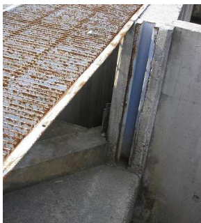
Slika 47 : Detajl nastavka za kovinsko zaklopko
