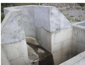
Slika 46 : Detajl rešitve težave z vtokom v ZBDV 10/61
