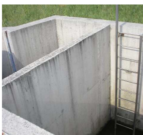
Slika 44 : Dostop do glavnega dela ZBDV-ja
