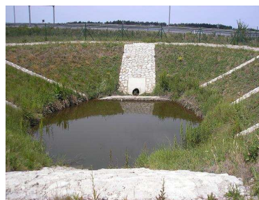
Slika 28: ZBDV B3/61 zemeljski del
